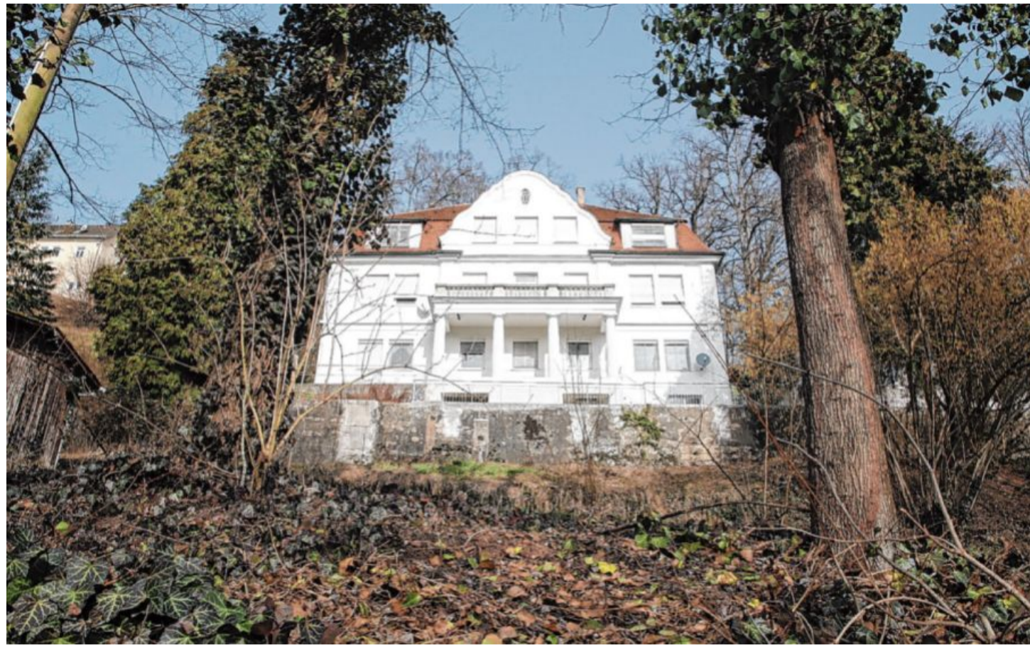
Die Salvatorvilla will der Schorndorfer Investor Gerald Feig aus dem Dornröschenschlaf erwecken. In und bei der Villa sollen zwischen Salvatorstraße und Salvator 27 Wohnungen entstehen. Noch in der Diskussion ist die Gestaltung des Geländes östlich der Villa. Foto: Tom
