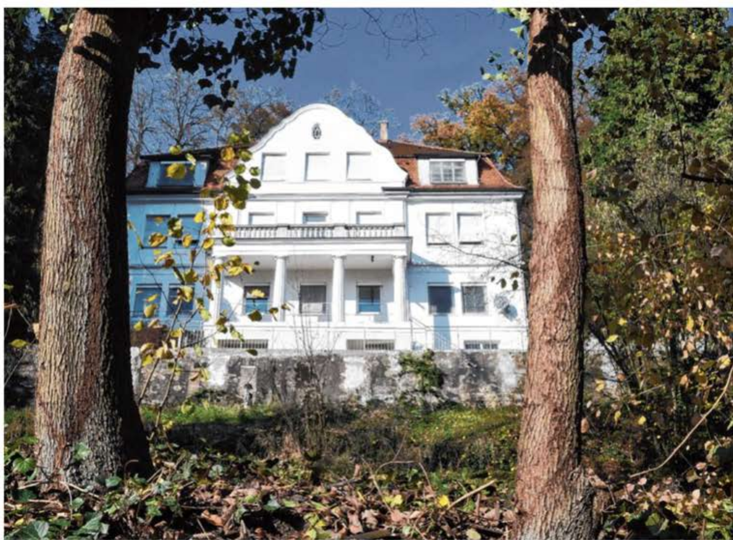
Der Schorndorfer Investor und gebürtige Gmünder Gerald Feig will die Villa unterhalb des Salvators sanieren. Sieben Wohnungen sollen dort entstehen. Weitere 20 Wohnungen sollen in drei Gebäuden an der Salvatorstraße entstehen.
